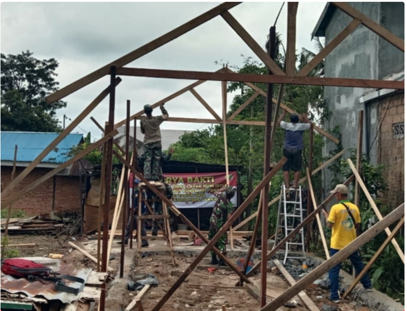
Setelah Dirobohkan " Kini Rumah Nursiah Dipasang Pondasi Dan Kuda - Kuda Rangka Rumah
